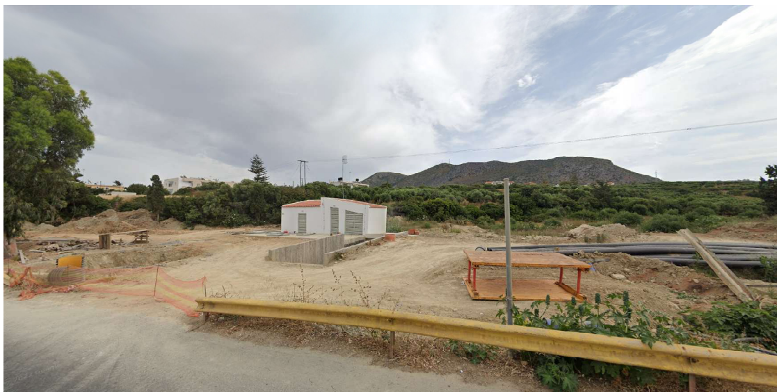
Φωτογραφία 4: Άποψη του γηπέδου του αντλιοστασίου ΝΑ 4.
