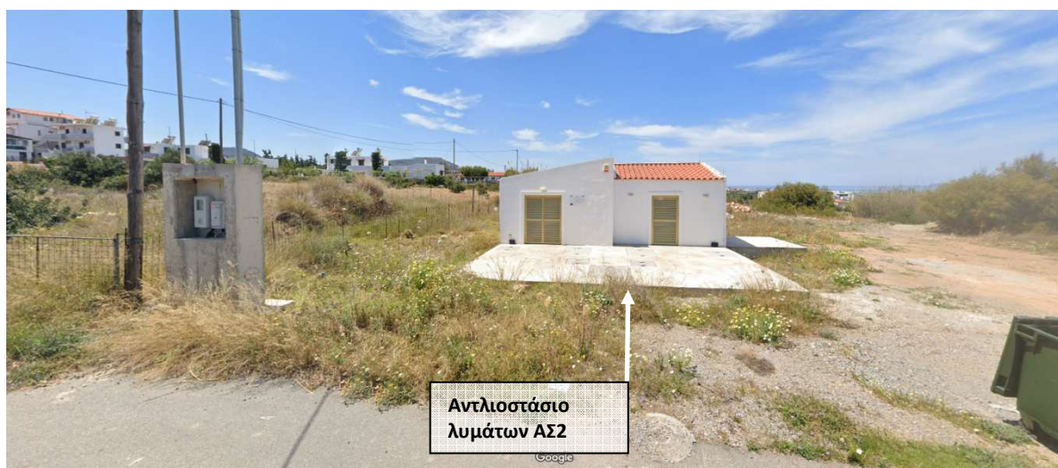
Φωτογραφία 2: Άποψη του γηπέδου του αντλιοστασίου ΑΣ2 Ανάληψης.
